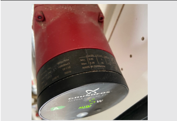
Alpha2 15-60 130 varmfordelingspumpe max. 45w fra 2012
