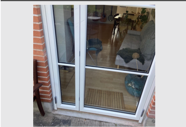
Ny dør i træ/alu ved bygning 54B
