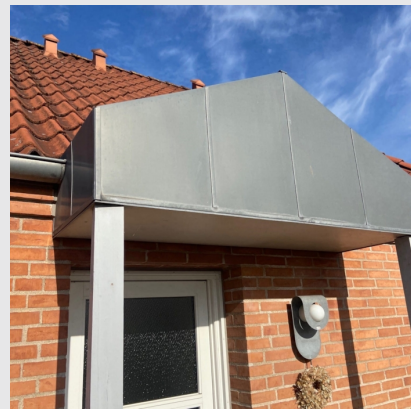
Facadebeklædning er udført i zink
