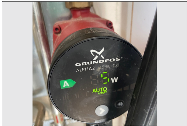
Alpha2 15-60 130 varmfordelingspumpe max. 45w fra 2012
