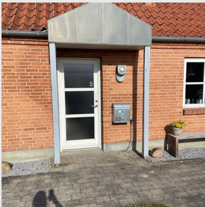
Facadebeklædning er udført i zink
