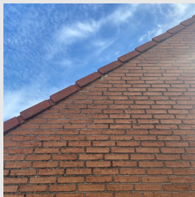
Sydgavl med reparation
